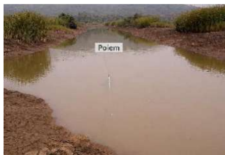
Figure 4: Poiem (buffer reservoir)
